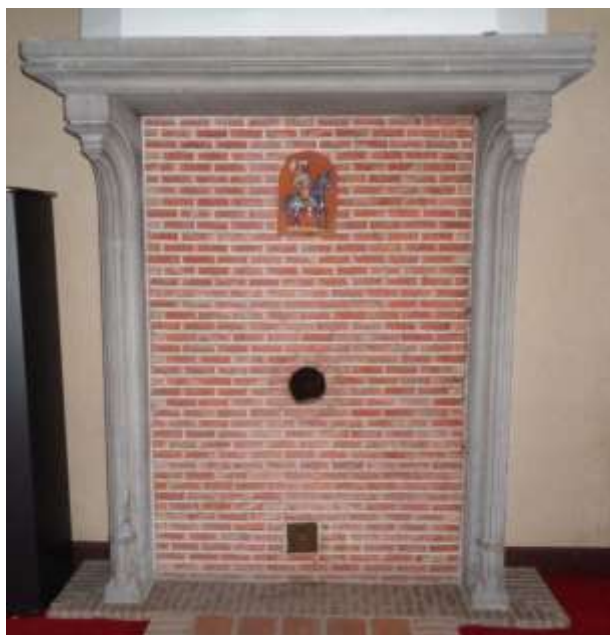
De dichtgemetselde open haard in de woonkamer op het gelijkvloers.
